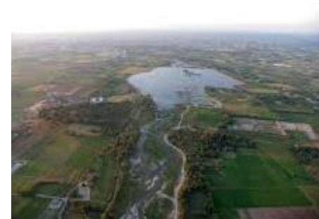
Cassa di espansione torrente Parma, azzerata pianificazione consumo di nuovo suolo
