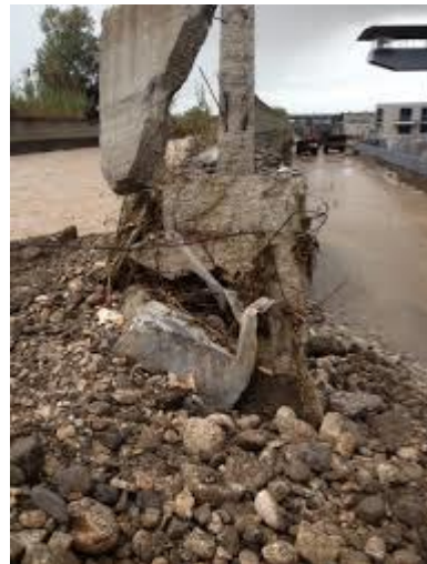
Ripristino della continuità dello smaltimento delle acque e potenziamento di alcune condotte
