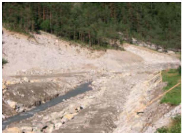
**Costruzione di argini con massicciate di massi e cemento in zone altamente franose**
