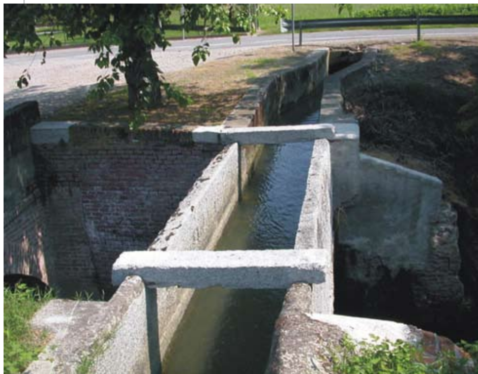
Ponte - canale in granito
