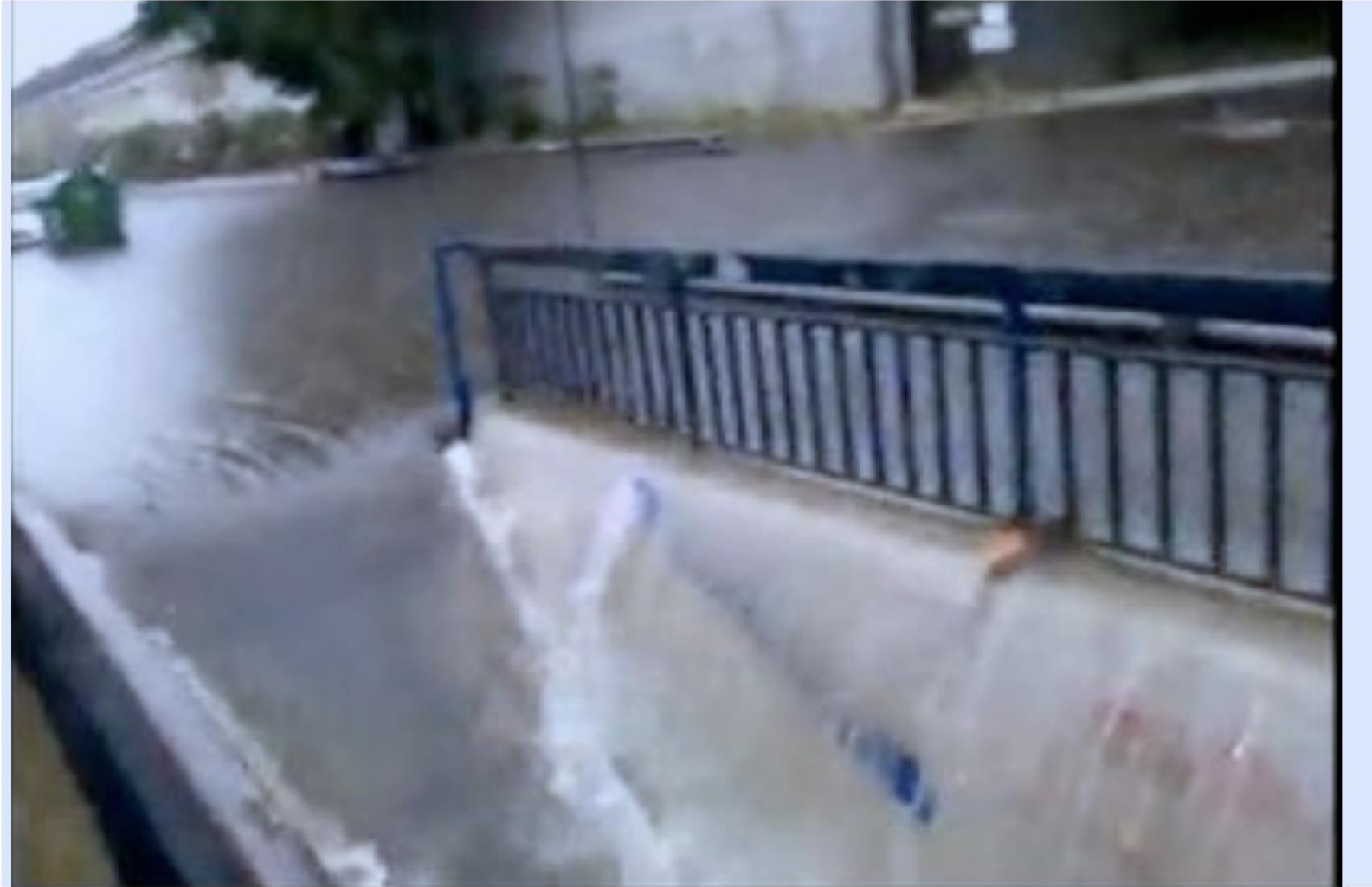
L'allagamento dell'ingresso Anagnina della Metro B (15 giugno 2014)
