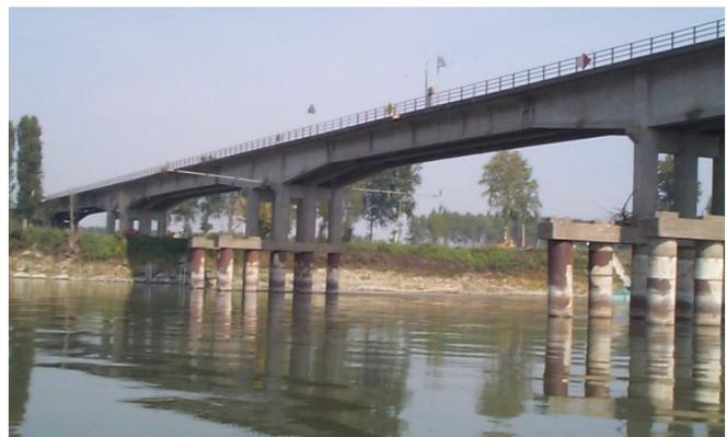
Sono uscite molte foto dopo il crollo del “Morandi” di Genova sui ponti del Po perché, come in molti altri fiumi, sono instabili anche a causa dell'abbassamento del letto!<sup>4</sup>
