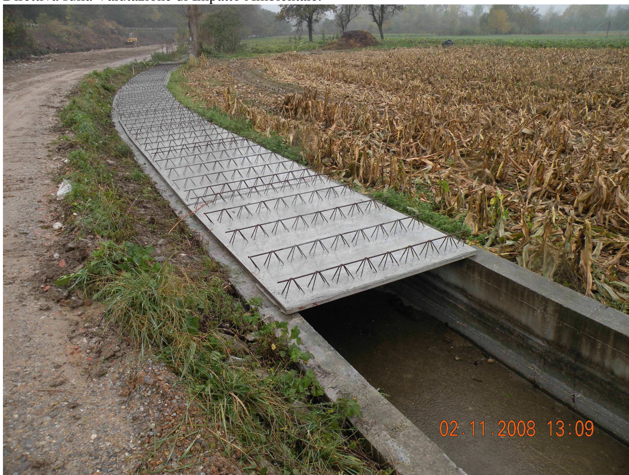
Tombinamento del canale (foto WWF Piemonte)
